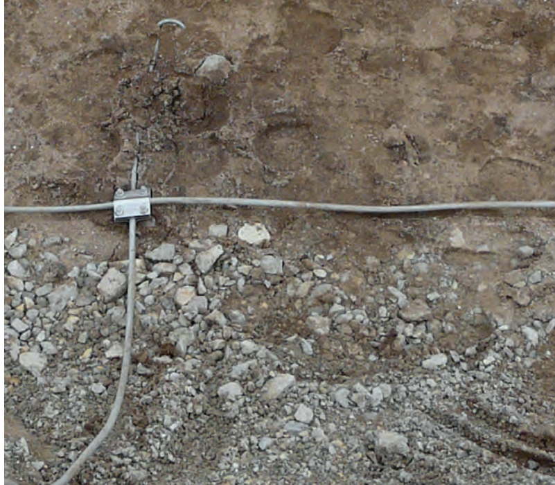
Uziom otokowy, drut okrągły ze stali nierdzewnej V4A
