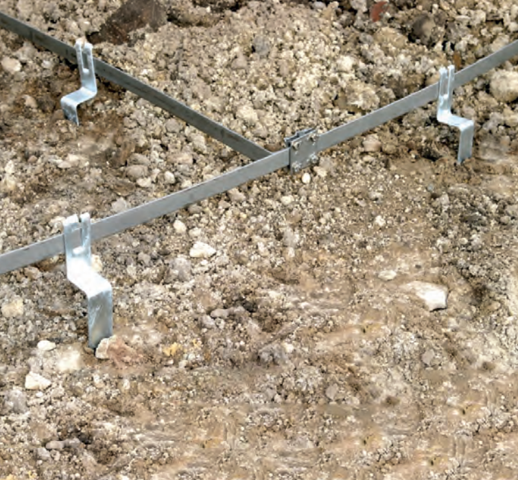
Uziom otokowy, płaskownik ze stali nierdzewnej V4A
