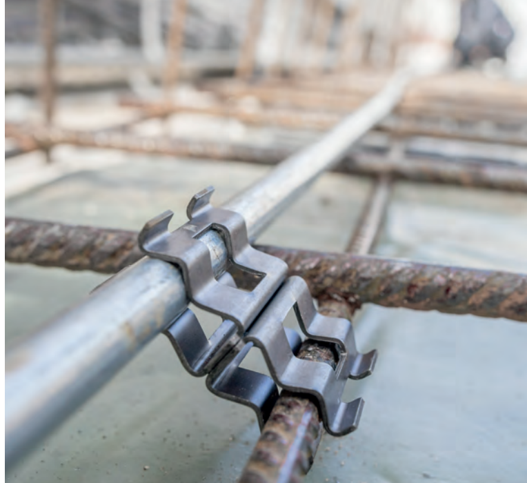
Połączenie uziomu fundamentowego ze zbrojeniem
