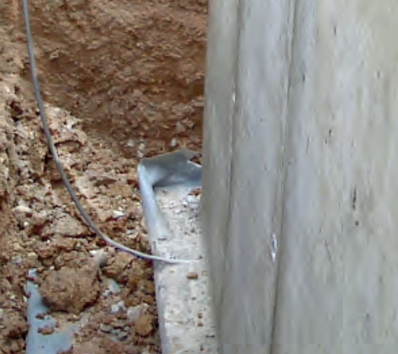
Pręt uziemiający ze stali nierdzewnej V4A
