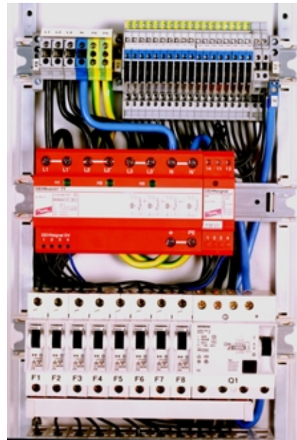
Figura 5: DEHNsignal DV instalado junto a DEHNventil
