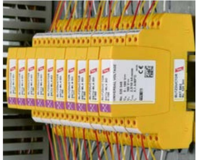
BLITZDUCTOR XTU para protección de líneas de señal y datos independientes. Ahorro de espacio diseñado en dos partes base y módulo de protección para montaje sobre carril DIN.
