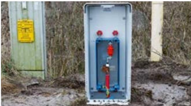
Conexión coaxial de la vía de chispas de separación para la protección de elementos aislantes bajo tierra.
