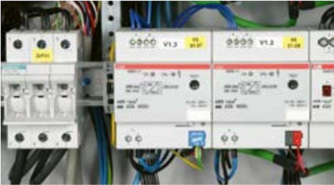
Descargador de sobretensiones con diseño terminal de bus adaptado a la resistencia de aparatos de sistemas KNX/EIB, con hilos de conexión. Homologación EIBA.
