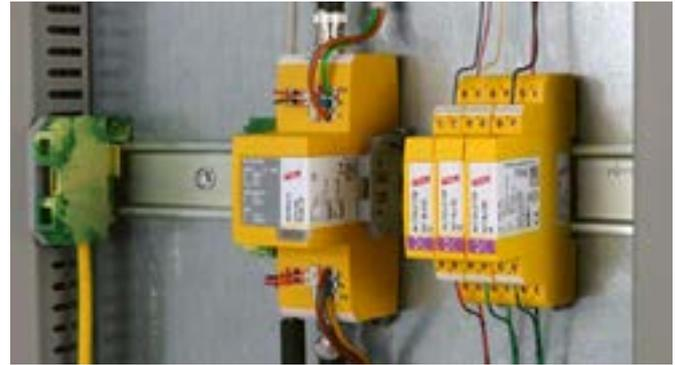
Descargador 3 en 1 DEHNvario, óptimo en requerimiento de espacio y aplicación para sistemas de cámara analógicos.
