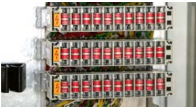
Descargador enchufable para sistemas LSA de la serie de construcción 2/10. Ejecución como bloque de protección para 10 pares de hilos con elementos de protección reemplazables individualmente.
