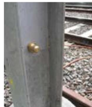
La DIN EN 50122-1 describe la utilización de limitadores de tensión en ferrocarriles de corriente continua y alterna para la „puesta a tierra abierta en ferrocarriles“ así llamada de componentes conductivos en zonas de líneas aéreas y tomas de corriente.
