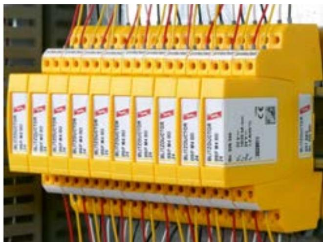
Descargador de sobretensiones universal, multipolar, modular para instalaciones de técnica de la información.
