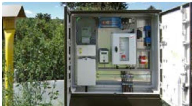
VCSD 40 IP65: Equipo de conmutación controlado por tensión con umbral de respuesta ajustable
