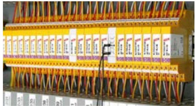
BLITZDUCTOR XT con un módulo de puesta a tierra (gris). Las líneas pueden ser probadas por medio del módulo de medida (gris con casquillos de conexión) sin desconectar los terminales.
