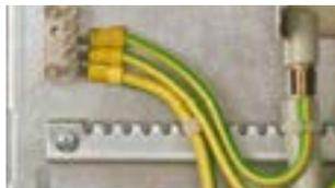
En el bloque central de toma de tierra se conectan conjuntamente todos los cables de compensación de potencial.
