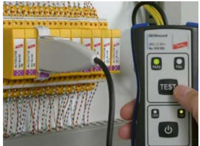
Verificación de un módulo de descargador con técnica RFID (LifeCheck)
