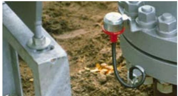
Vía de chispas de separación homologada por ATEX para la compensación de potencial de protección contra el rayo según IEC 62305 con cable de conexión flexible.
