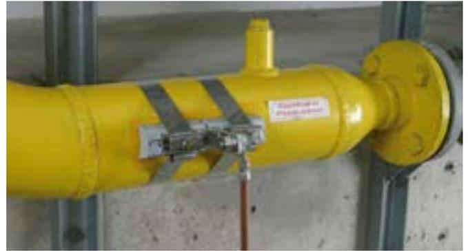
Abrazadera de banda para el contacto eléctrico de tuberías en la zona Ex, para la implementación de la compensación de potencial de protección contra el rayo según EN 62305-3 (VDE 0185-305-3).
