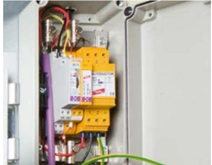
Protección compacta contra sobretensiones de bornas atornilladas para conductores de varios hilos. Montaje en carril DIN.
