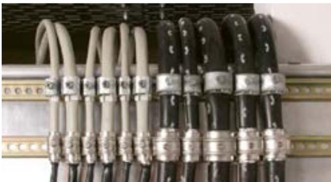
Sistemas de conexión de apantallamientos de cable para carriles de sujeción. Compensación de potencial mediante bornas de de resorte.
