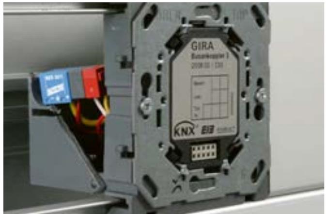
Protección de una unidad de acoplamiento de bus KNX por medio del descargador de sobretensiones BUSStector montado sobre un terminal de bus en el panel de montaje de la conducción de cables.
