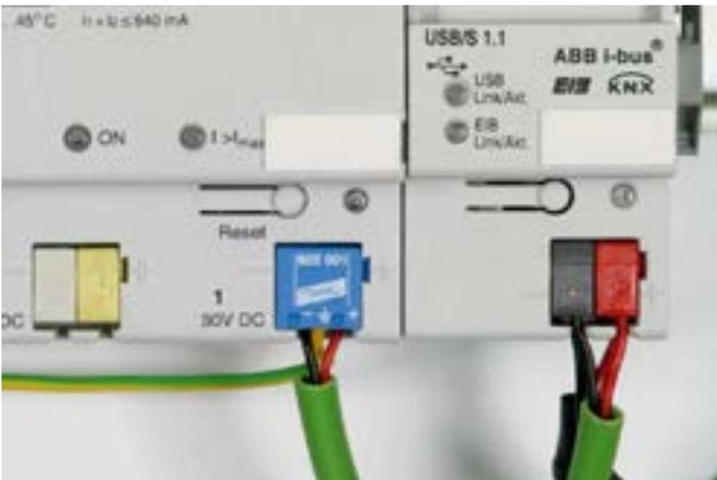
Protección de fuente de alimentación KNX por medio del descargador BUSStector montado en la ranura del elemento terminal del bus estándar.
